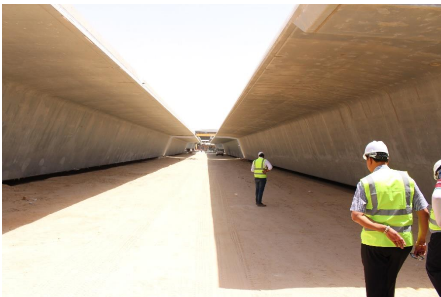
Figure 6. Éléments de pont finis prêts à être transportés et installés
