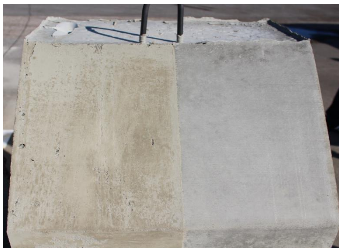
Figure 1. Béton coulé avec un coffrage imperméable traditionnel (à gauche) et mis en œuvre avec une peau de coffrage (à droite).
